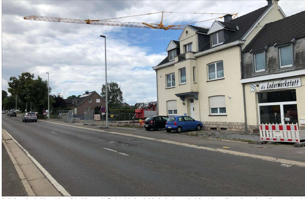
Zwischen den beiden „Wiesen“-Residenzen befindet sich das Gebäude, in dem seit vielen Jahren die „Lederwerkstatt“ untergebracht ist. Links davon entstehen die „Ketteniser Wiesen“. Foto: Annick Meys
